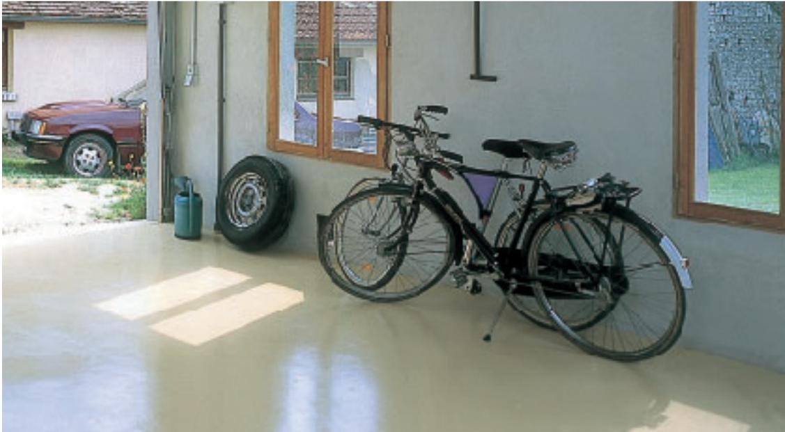
**L**es sols en ciment ont deux gros défauts : ils se tachent très facilement et produisent de la poussière en permanence. Qu'il s'agisse d'une dalle en béton surfacée ou d'une chape de mortier, lorsque l'on marche dessus le ciment s'use, se désagrège petit à petit et forme de la poussière.
